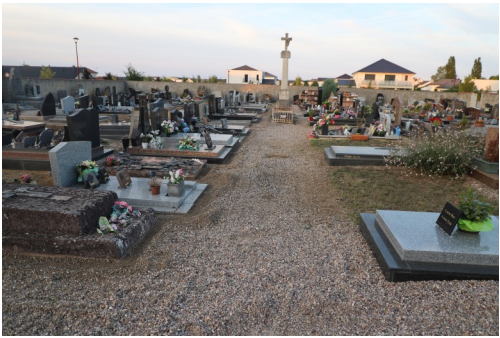
Avant intervention Velaine-en-Haye
